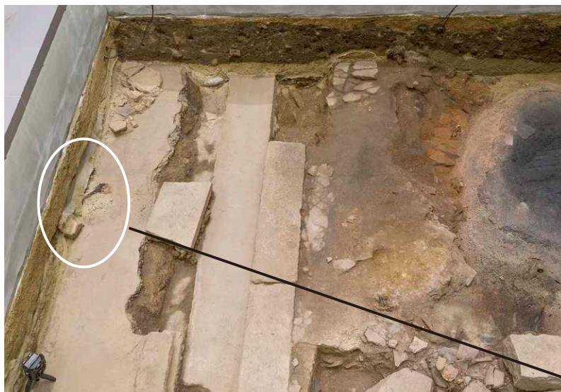
2022/5/16 崩壊を確認した。
