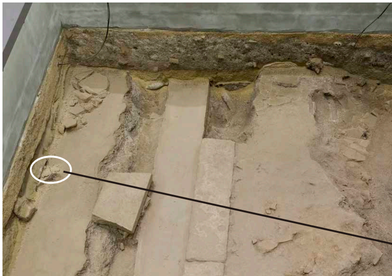
2026/6/15 崩落を確認した。
