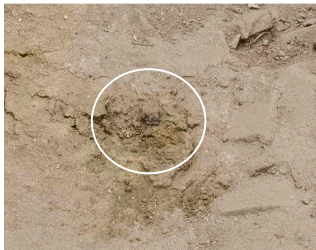
2026/6/15 析出箇所周辺に大きな変化は見られない。 周辺の亀裂については（4）参照。
