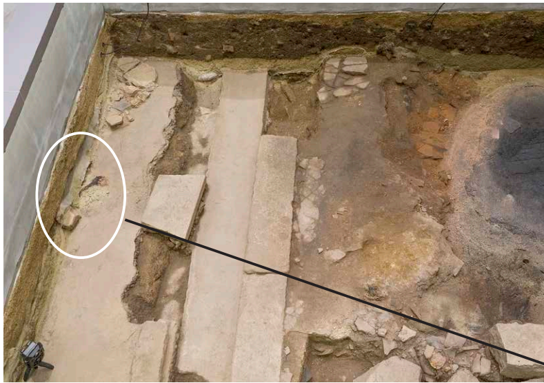
2022/5/16 崩壊を確認した。
