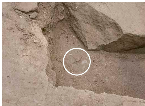
2022/8/24 拡大写真 亀裂が初めて確認された。
