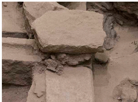
2024/7/16 下層部の土層部分が崩壊した。
