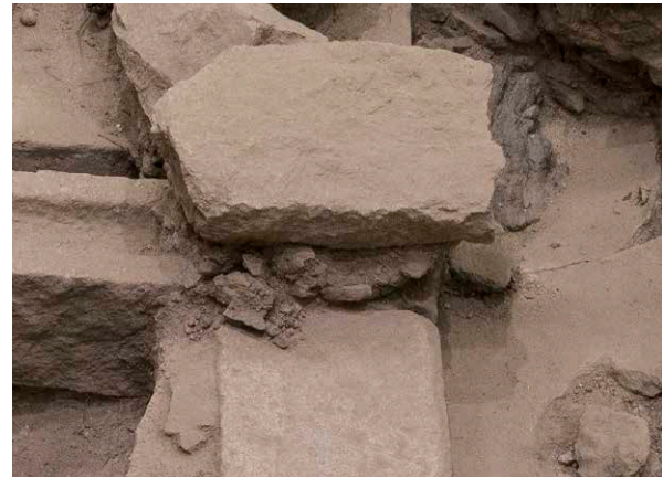
2024/7/16 下層部の土層部分が崩壊した。
