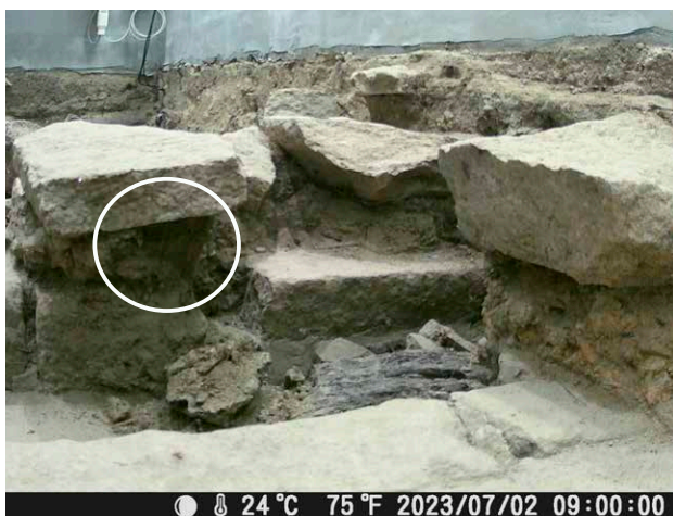
2023/7/2 定点カメラ画像 石列下層部の土層部分の崩壊が進む。
