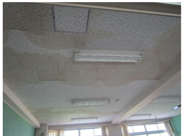
④多目的教室（天井）
