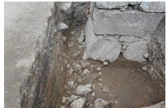
写真8 内堀裏石垣の設置面(T4-2)
