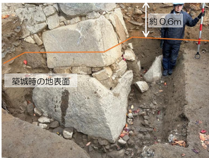
写真1 天守台南東部
