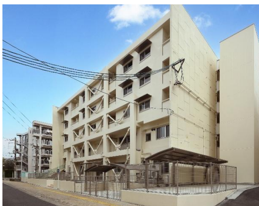
福島第26アパート外観（耐震改修）
