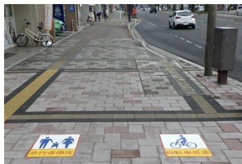
〔ピクトグラムの設置〕
