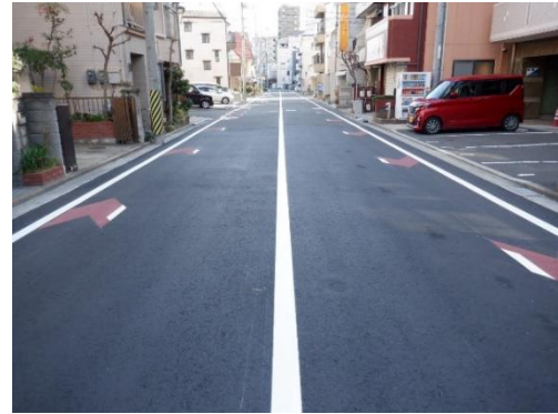
〔車道混在(矢羽根型路面識示)(南区)(R5 整備)〕
