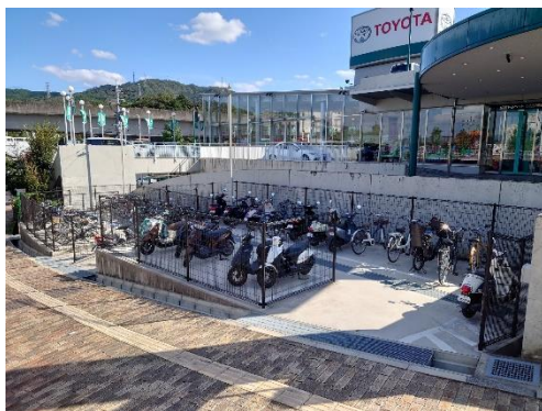
〔広域公園前駅駐輪場(R2 完成)〕
