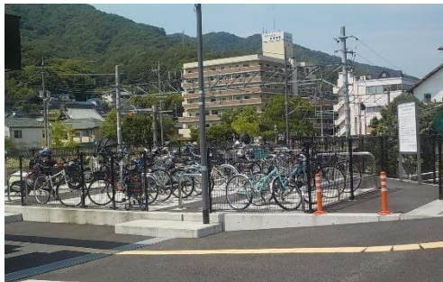
〔安芸中野駅市営無料駐輪場(R3 完成)〕
