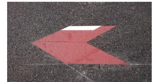
《矢羽根型路面標示への白線設置》
