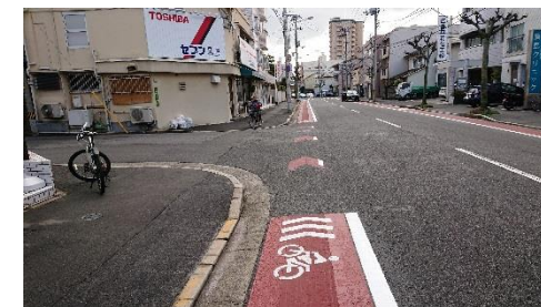
《矢羽根型路面標示への白線設置》
