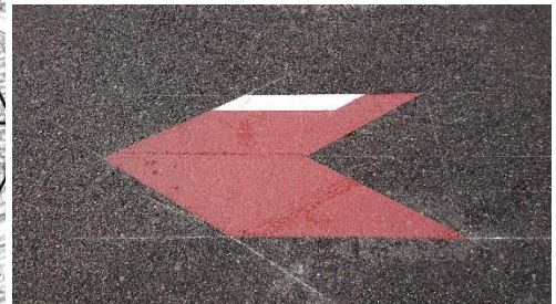
《矢羽根型路面表示(白線設置)》
