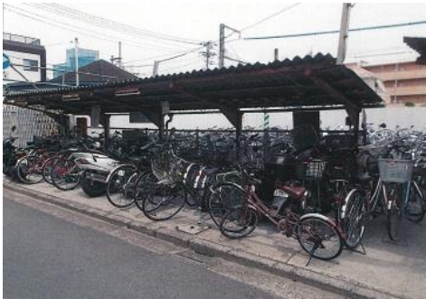
《駐輪場の整備前の状況
