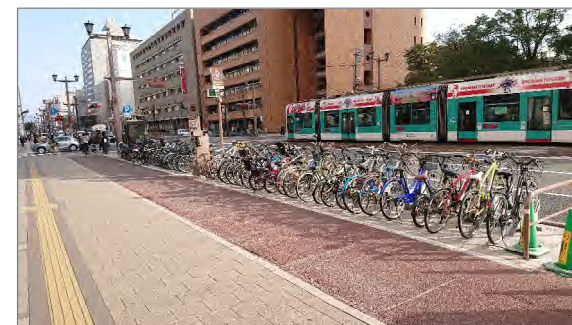
〔国道 54 号(H29 整備)〕
