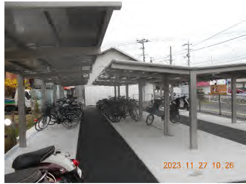
写真 梅林駅 (R5 屋根新設)
