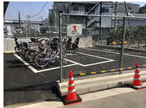
写真 天神川駅北第二 (R2 完成)
