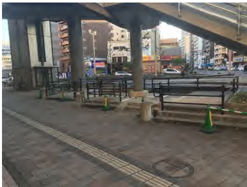
写真 鷹野橋第二 (R2 完成)
