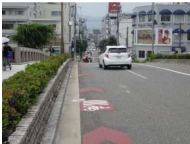
《車道混在での整備(市役所北側路線)》
