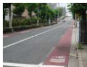
走行方向を示す路面標示
