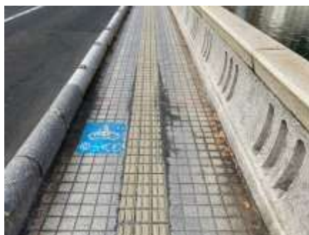
《整備状況（緑大橋）》
