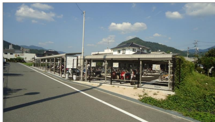
〔JR河戸帆待川駅駐輪場の整備(新設)〕
