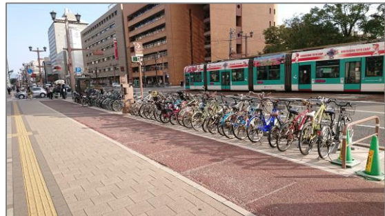
〔国道54号(H29 整備)〕
