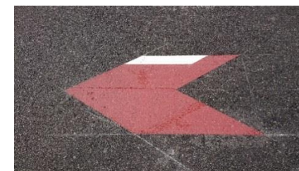
〔整備状況：矢羽根型路面標示への白線設置〕
