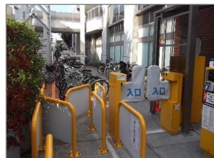
〔整備状況：NTTクレド白島ビル駐輪場(H30)〕
