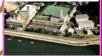
江波水資源再生センター
