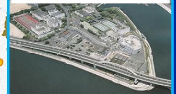
千田水資源再生センター
