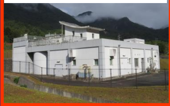
和田水資源再生センター
