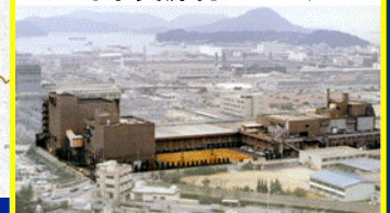
旭町水資源再生センター
