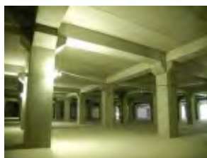
大州雨水貯留池
