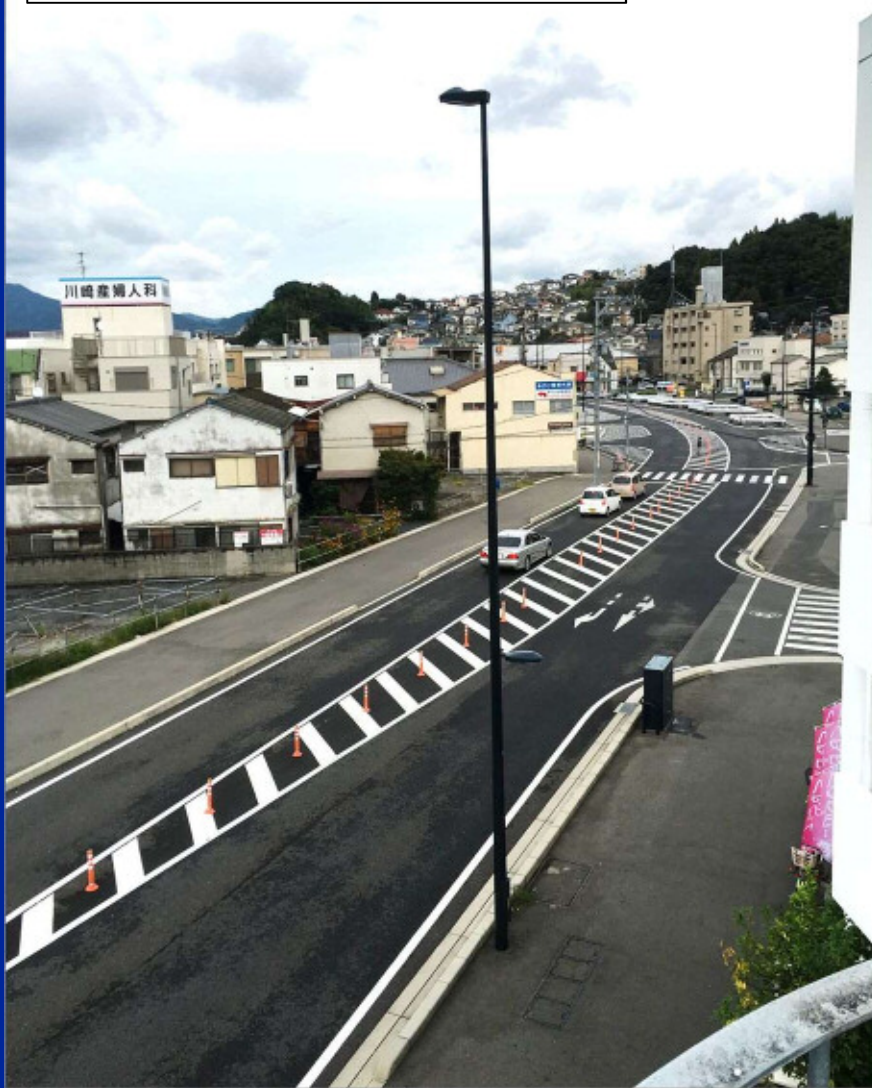
8工区(暫定道路整備状況)
