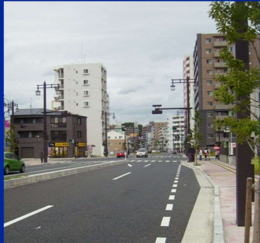
整備事例(段原東部土地区画整理事業区間)
