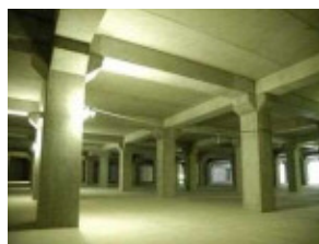
大州雨水貯留池
