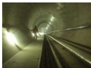
雨水幹線 (千田雨水1号幹線)
