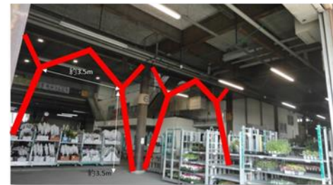
変形筋交いを設置したイメージ
