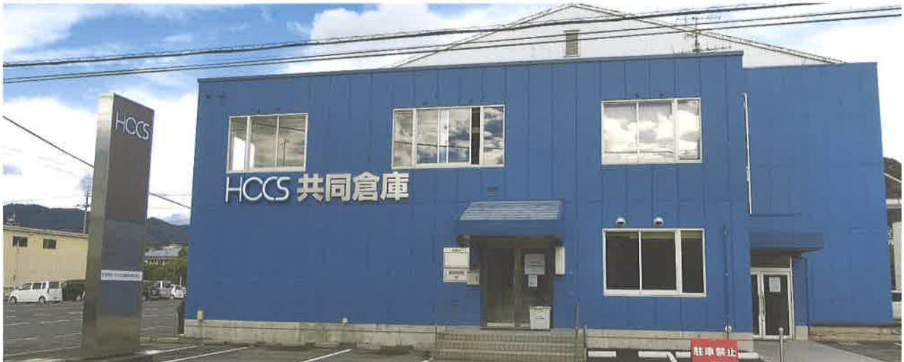
組合共同倉庫 事務所の新設
