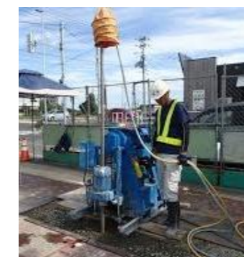
小型機械（薬液注入工法）
