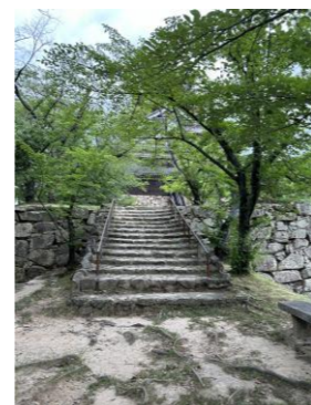
写真 2-8 東小天守台側階段 D
