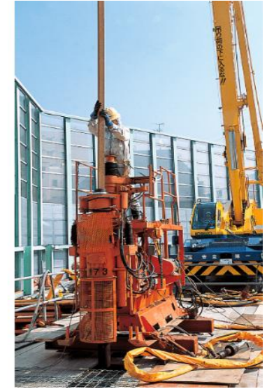
小型機械 （高圧噴射攪拌工法）
