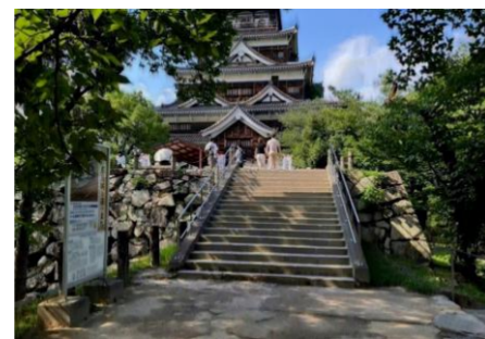
写真 2-6 南小天守台側階段 B
