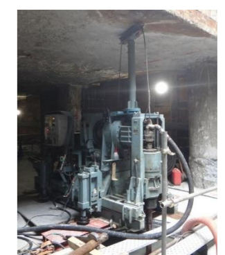
小型機械（杭工法）
