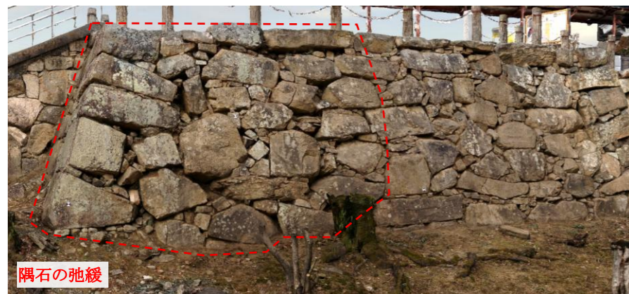
南小天守石垣の東面、南東隅石周辺の状況
