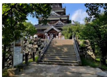
南小天守台側階段B
