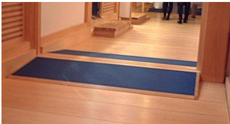
写真-資 23 スロープ設置例（熊本城本丸御殿）
