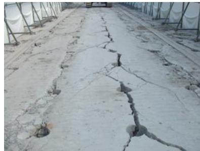
写真 23 コア穴破碎器 床の施工例
