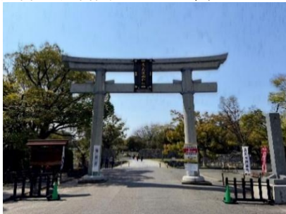
写真1 鳥居 石垣～建屋間 6.7m
