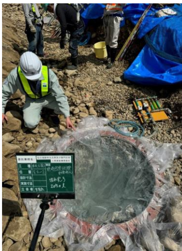
現場密度試験(水置換法)
