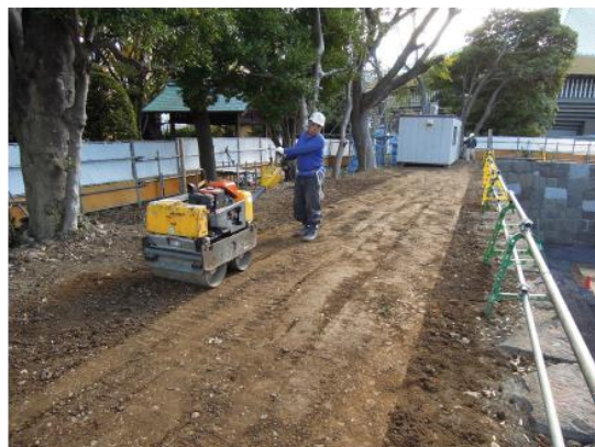
写真 28 振動ローラ使用状況
