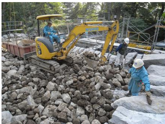
写真 27 0.18 m 3 バックホウ使用状況
