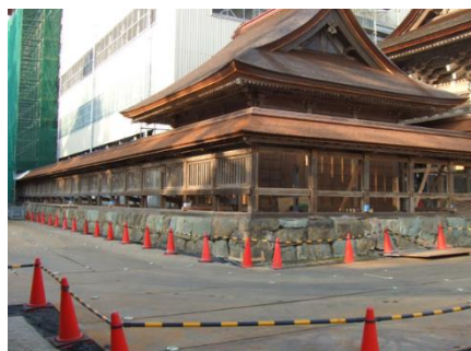
写真9 史跡内での道敷鉄板養生の例
