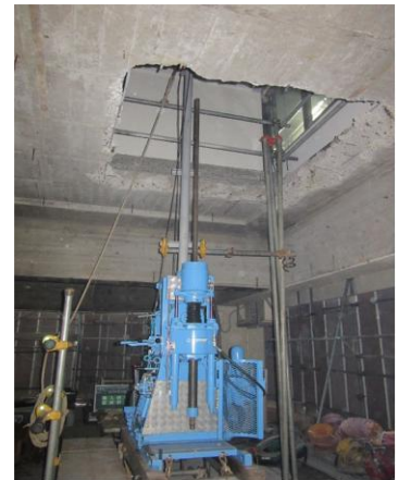
屋内作業状況
