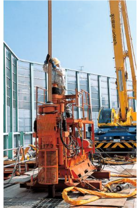
小型機械 (高圧噴射攪拌工法)
