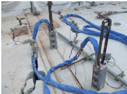
写真 22 コア穴破碎器
