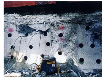
写真 24 コア穴破碎器 壁の施工例
