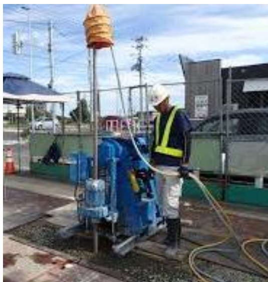
小型機械 (薬液注入工法)
