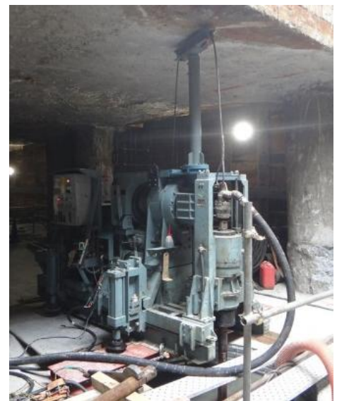
小型機械 (杭工法)
