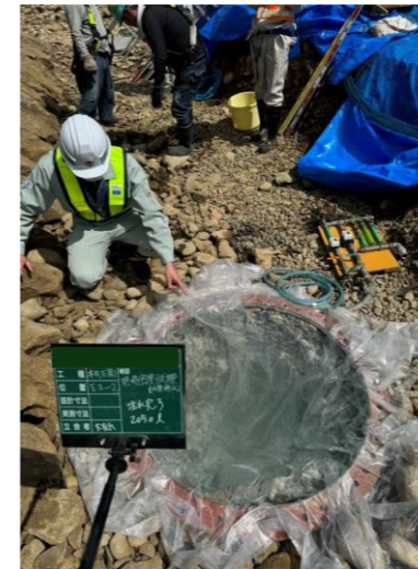
現場密度試験 (水置換法)
