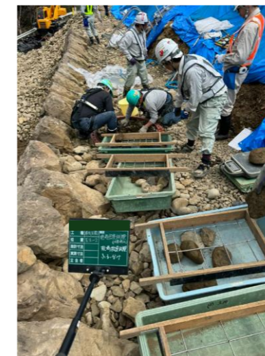
粒度試験 (現地作業)
