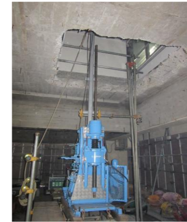
屋内作業状況
