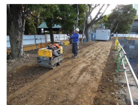
写真 23 振動ローラ使用状況
