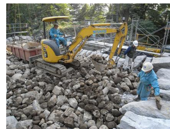
写真 22 0.18 m 3 バックホウ使用状況
