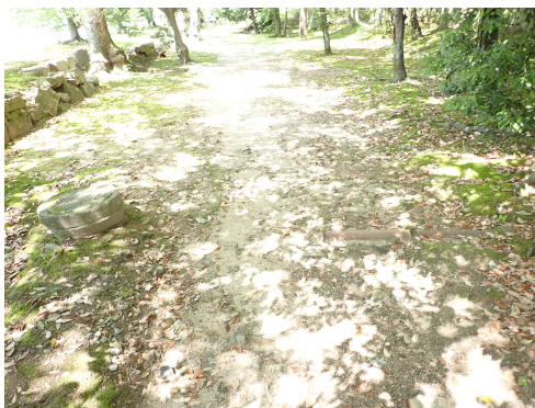
写真 10-1 本丸下段西側の土砂流出状況
