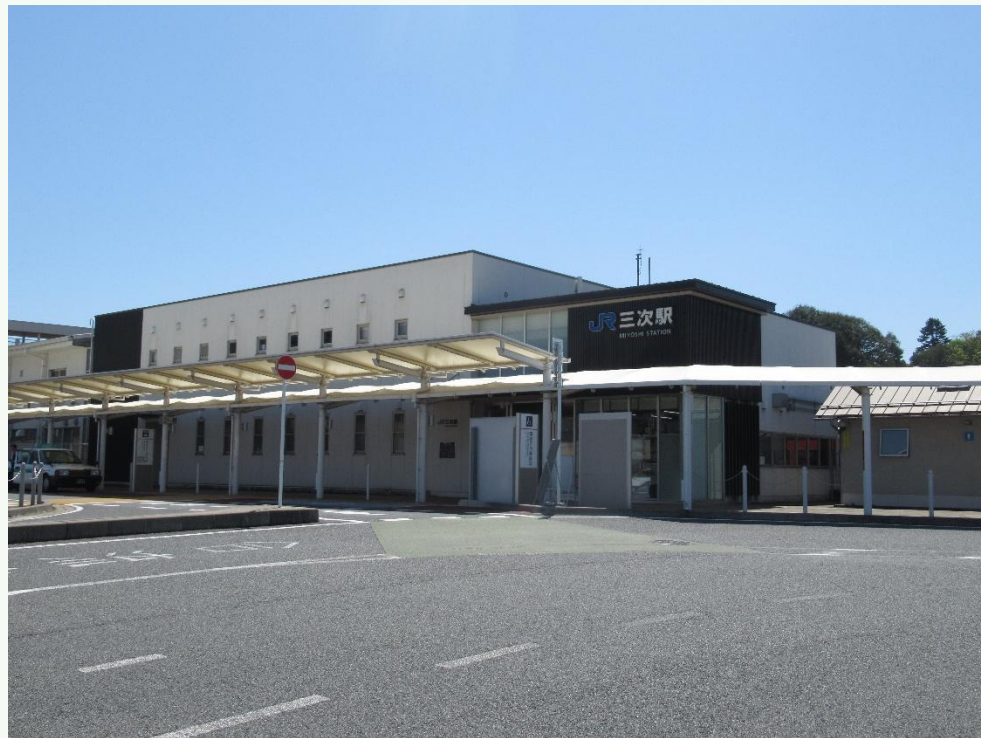
三次駅舎外観
