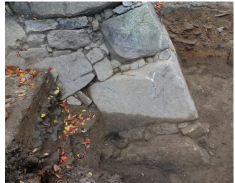
天守台南東部石垣基礎部
