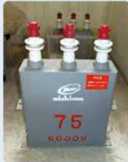
電力用コンデンサー
