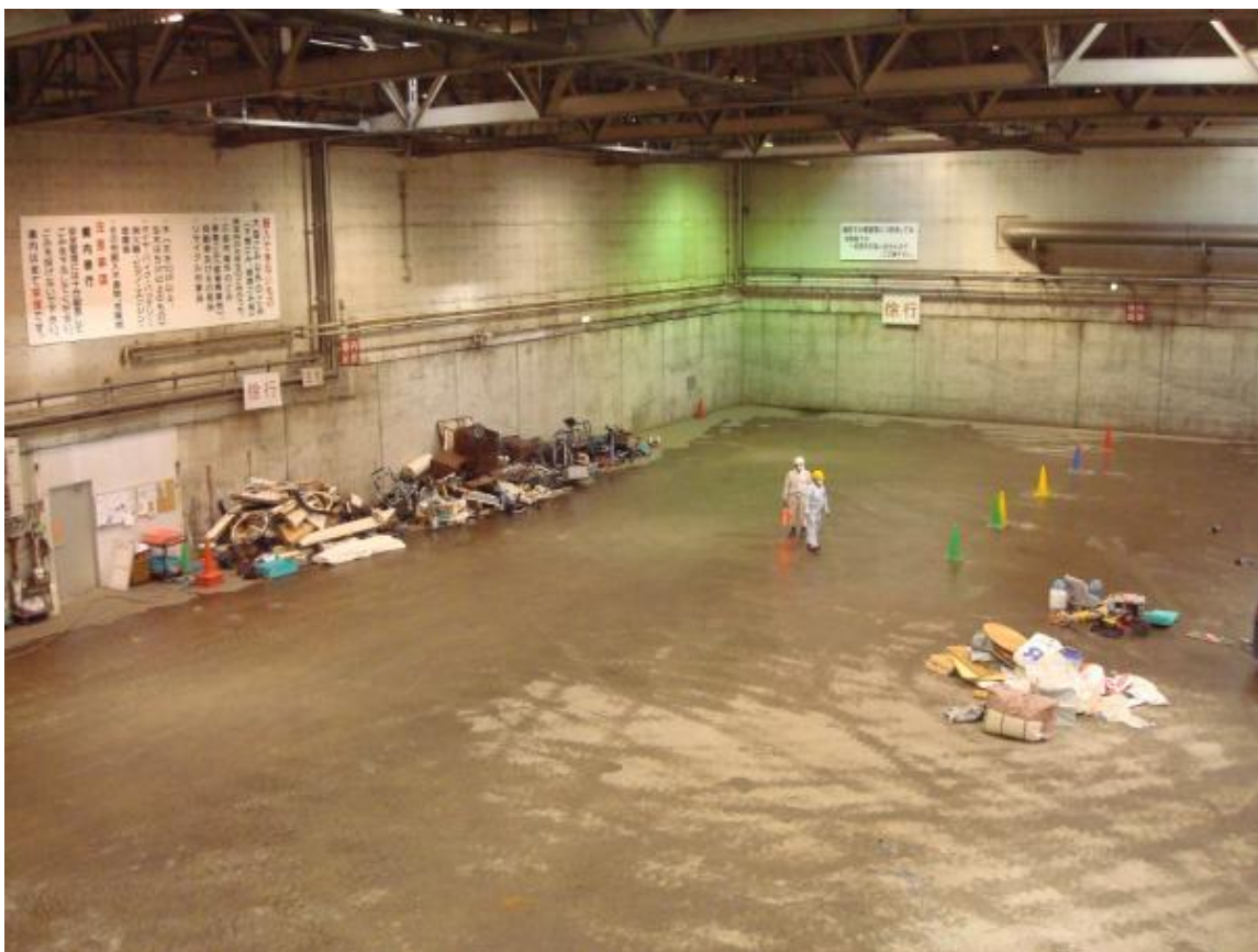
（投入ステージ積置場）
