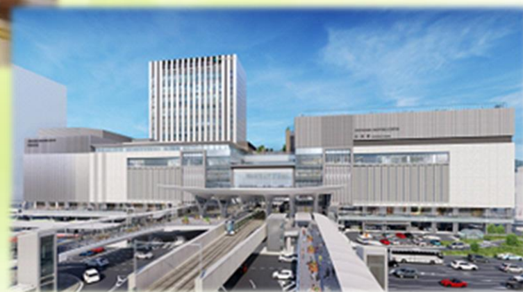
JR新広島駅ビル 令和7年春開業
