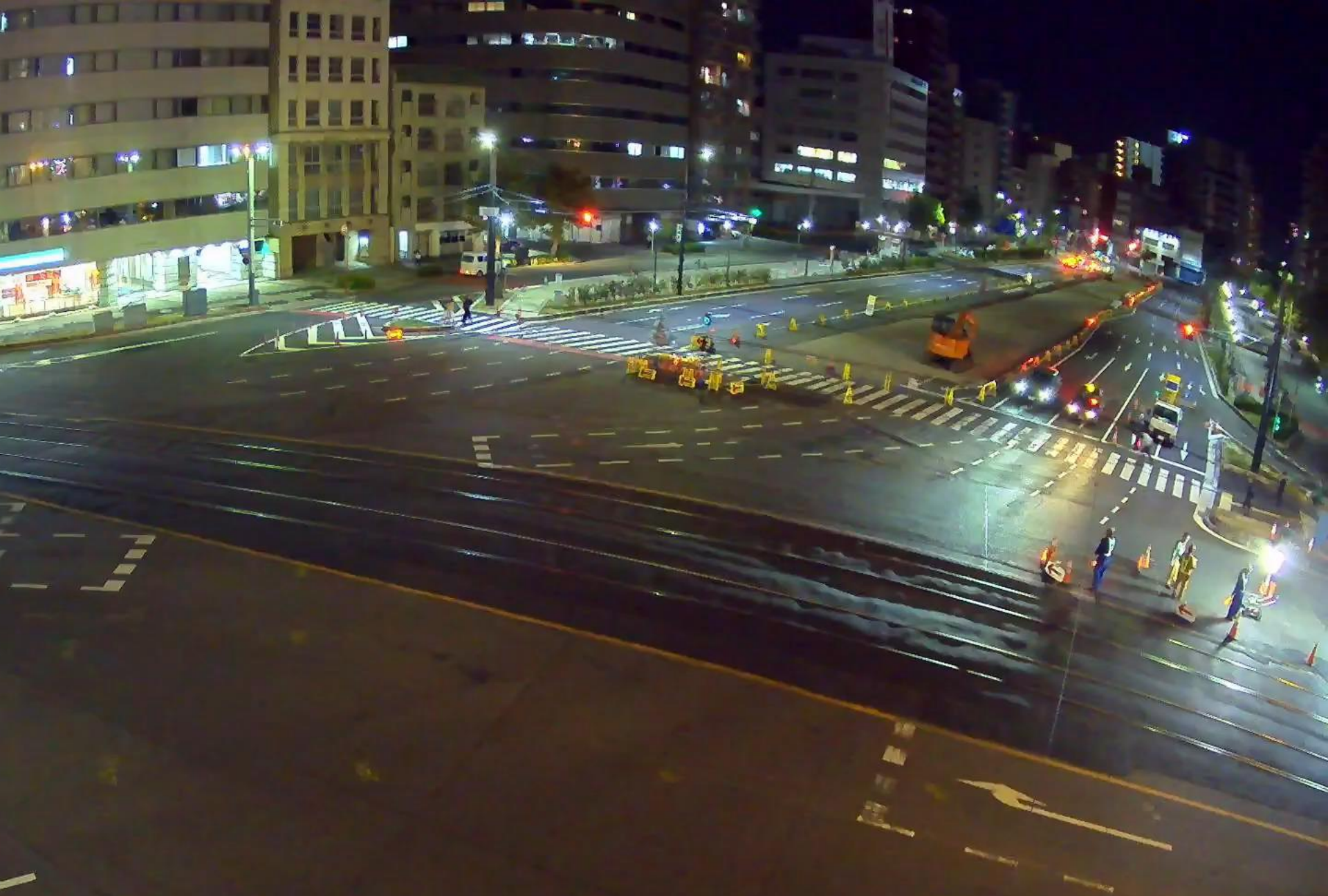
稲荷町交差点の軌道ブロック設置
