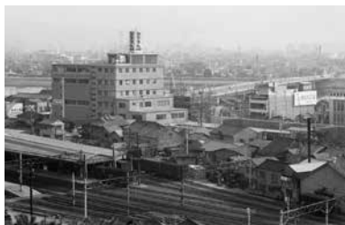
7 ひろでん会館と国鉄己斐駅★ 昭和40（1965）年
