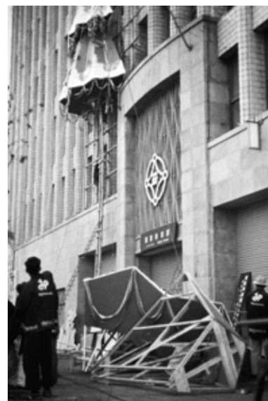
福屋クリスマス装飾 設置作業★ 昭和 30 (1955) 年 11 月頃
