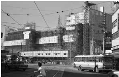
19 広島駅 建設中の駅ビル★ 昭和 40 (1965) 年夏頃
