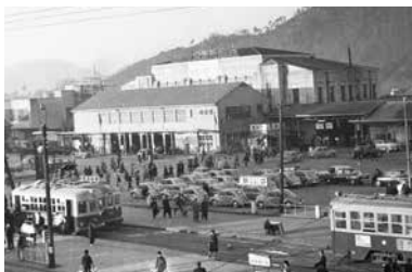
17 広島駅 駅舎★ 昭和 33 (1958) 年
