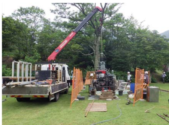
東京湾野水活動センターこども村 敷地及び地質調査事務所 17-1 Bor No. 3 マシン高上げ高 GL+0.30m以上 株式会社セトウチ 泥水溜め
