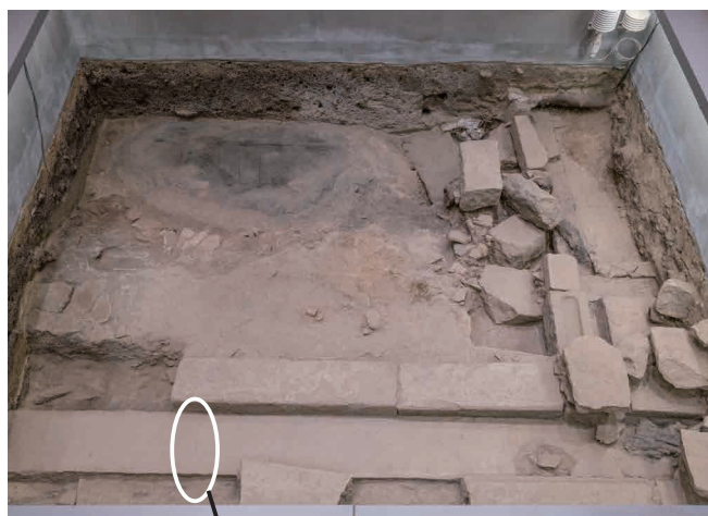
2022/8/24 亀裂を確認した。
