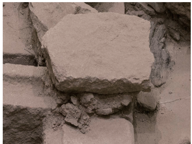
2024/7/16 下層部の土層部分が崩壊した。
