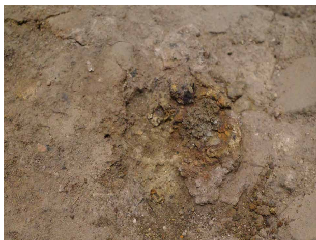
2023/9/14 析出物除去後の様子。
