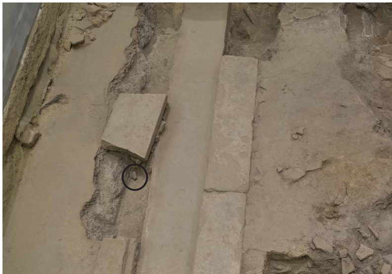
2024/8/15 レンガ片の崩落を確認した。
