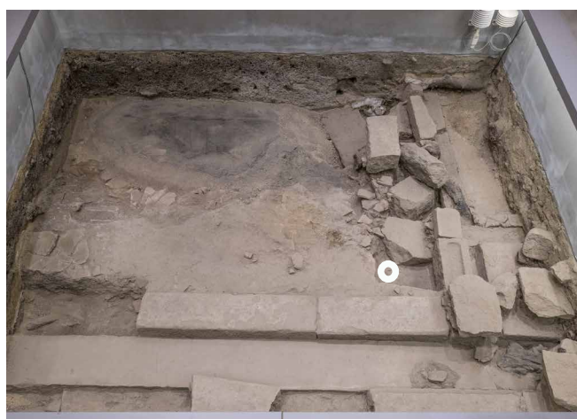
白丸部分に亀裂を確認した。
