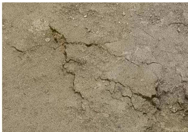
2025/4/18 亀裂 縦約 12.2cm 横約 24.5cm 白丸部分の亀裂及び表層の隆起は、先月からほとんど変化が見られない。
