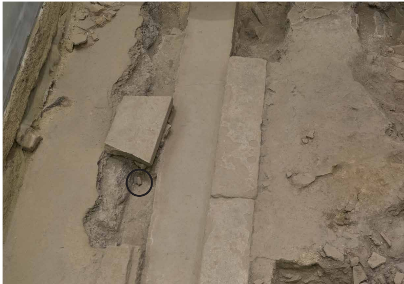
2024/8/15 レンガ片の崩落を確認。
