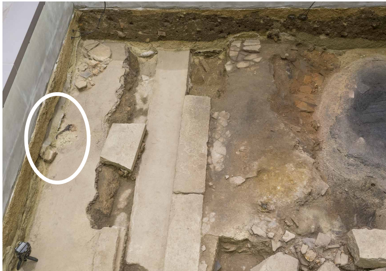
2022/5/16 丸印の部分が崩壊。
