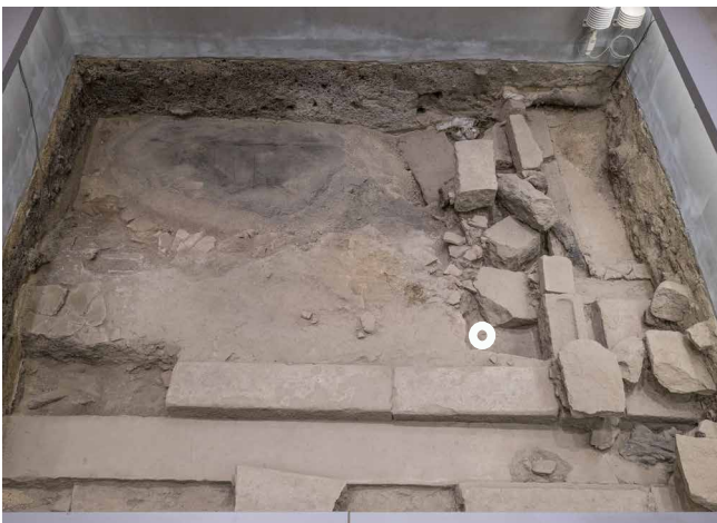
白丸部分に亀裂を確認した
