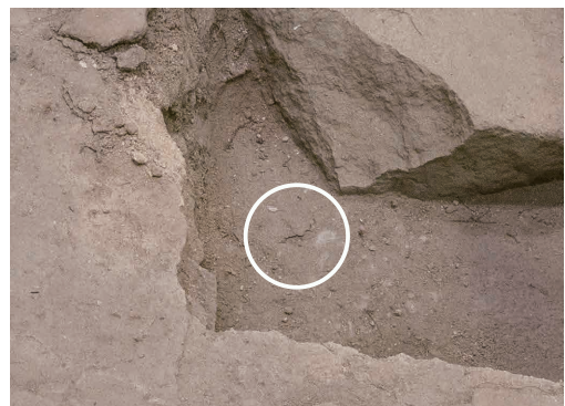
2022/8/24 拡大写真 亀裂が初めて確認された。
