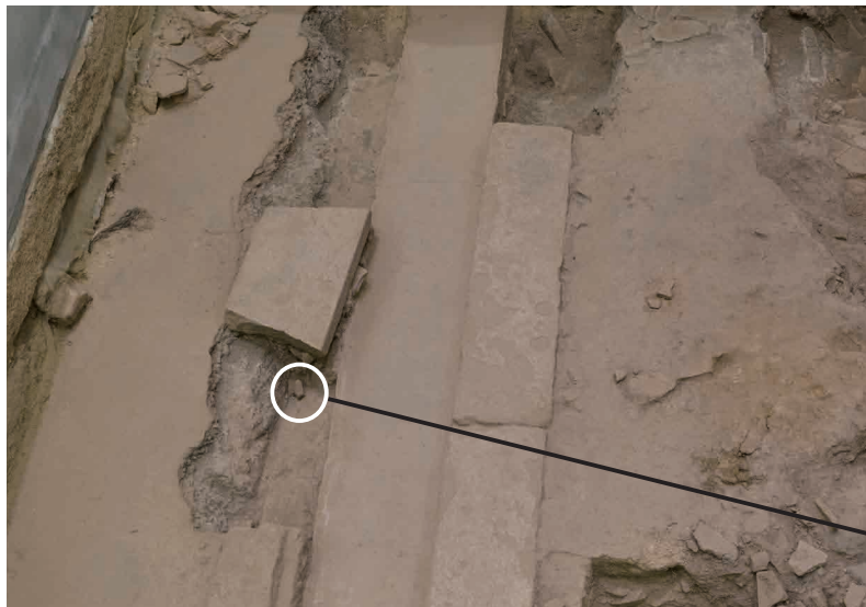
2024/8/15 レンガ片の崩落を確認した。
