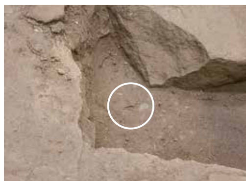
2022/8/24 拡大写真 亀裂が初めて確認された。
