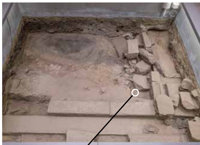
2022/8/24 亀裂を確認した。
