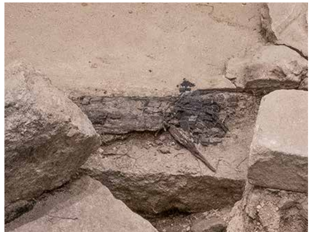
2022/7/14 崩壊箇所が広がる。
