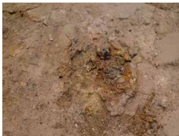
2023/9/14 析出物除去後の様子。
