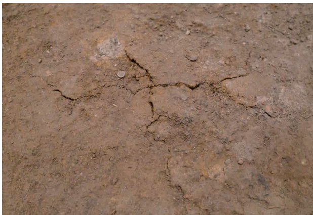
2023/4/24 亀裂 縦約 5.4cm 横約 12.6cm
