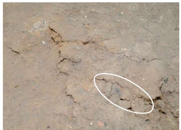
2025/10/15 亀裂 縦約 12.4 cm 横約 24.8cm 亀裂及び表層の隆起は、わずかに進行している。
