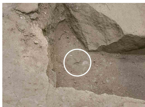
2022/8/24 拡大写真 亀裂が初めて確認された。
