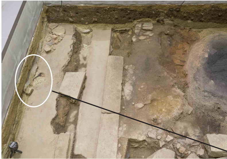
2022/5/16 崩壊を確認した。
