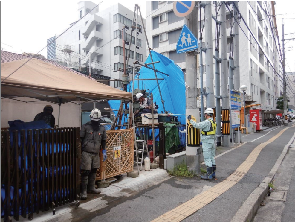
写真 電柱からの距離測定状況
