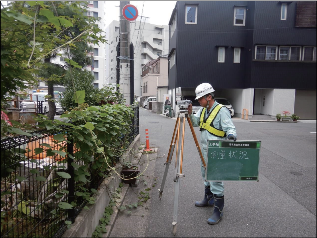
写真 水準測量状況
