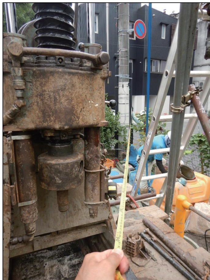
写真 電柱からの距離測定状況
