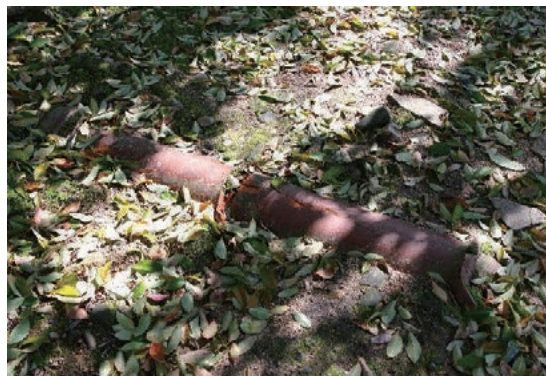
雨水排水管の露出
