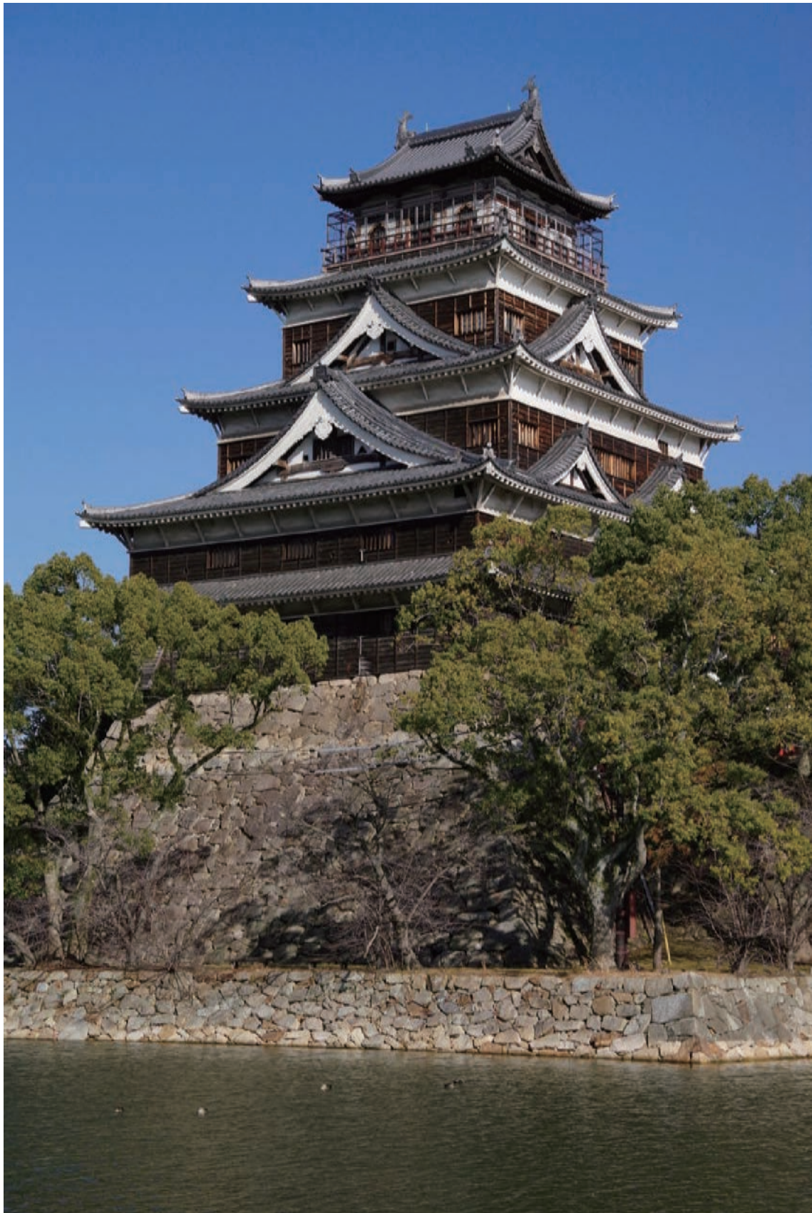
図 1-16 広島城天守（外観復元）（北西から）
