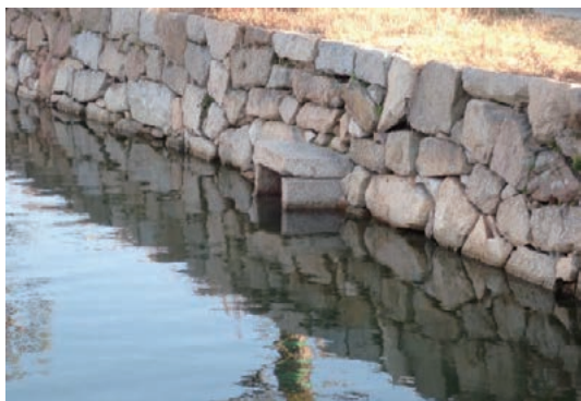
[5] 内堀南側暗渠
