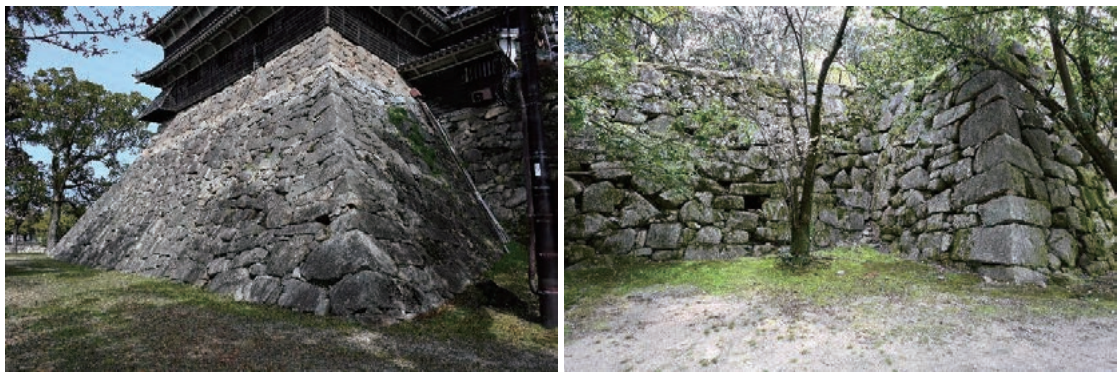
図2-24 広島城の石垣（上：天守台、下：東走櫓）
