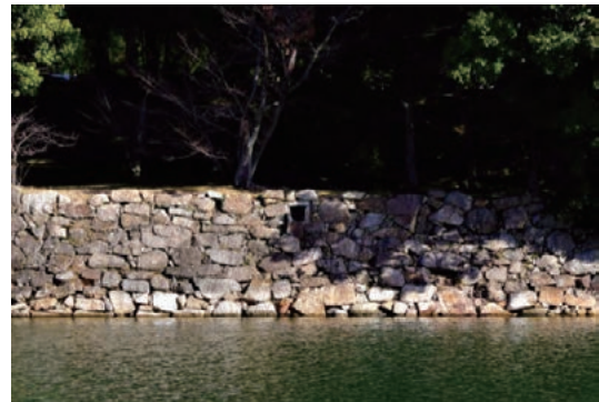
[8] 石垣（西内堀北側）
