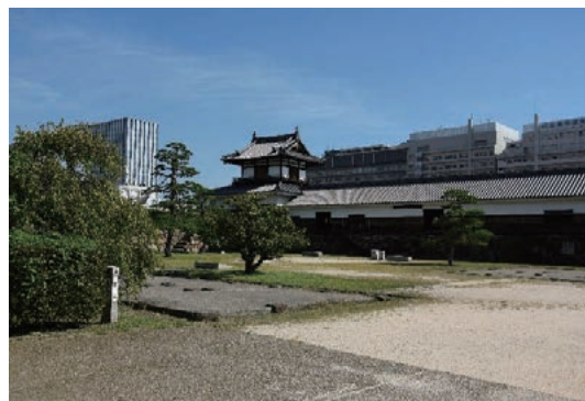
土橋から復元建造物を望む
