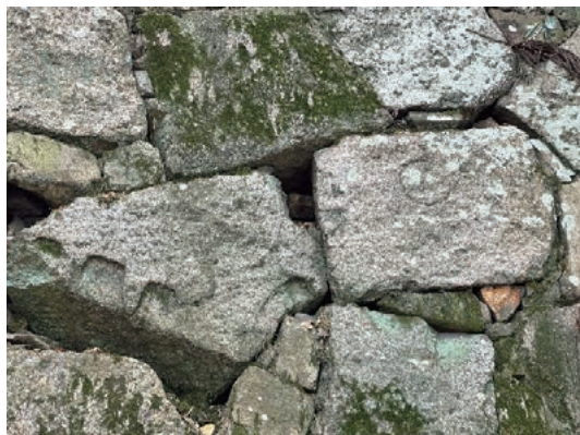
[5] 南側石垣西面の築石に見られる加工痕
