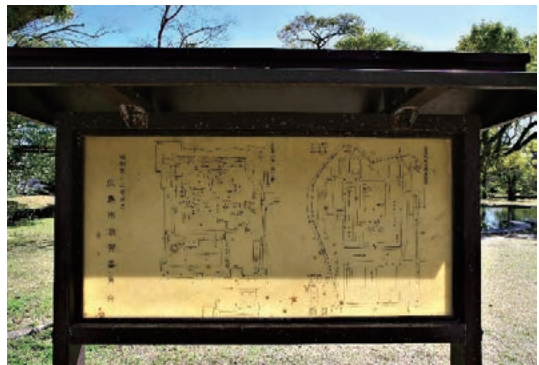
説明板の劣化（本丸）
