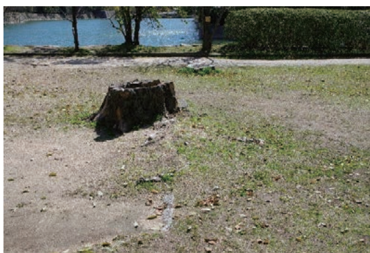
[3] 北西緑地帯に露出する埋没石垣の天端石
