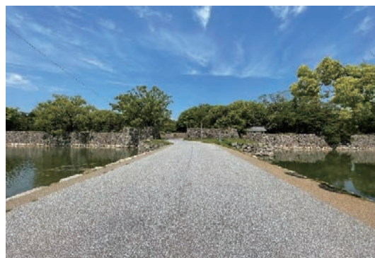
裏御門跡前土橋
