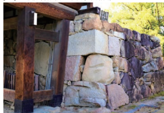
[22] 被爆の痕跡が残る石垣
