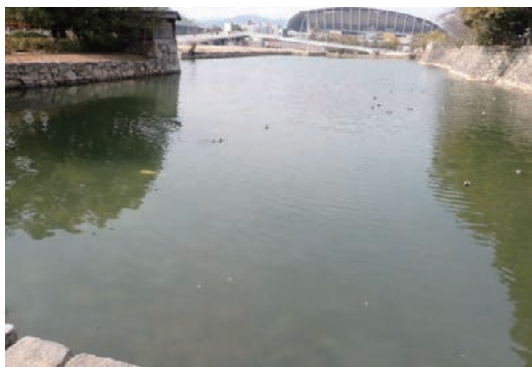
[1] 二の丸北側内堀（土橋西）
