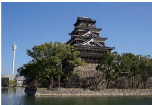
[9] 石垣（西内堀北側）
