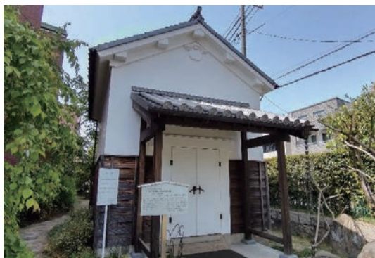
[3] 学問所内の土蔵（旧重谷家土蔵）
