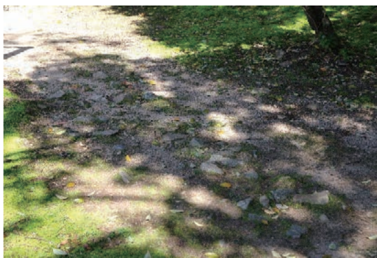
本丸下段西側の土砂流出状況
