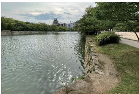
堀の石垣の天端石
