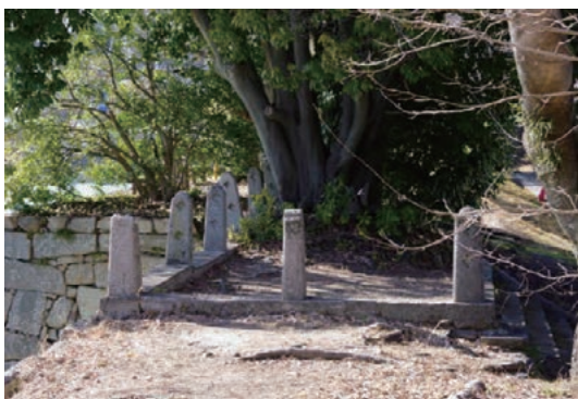
[21] 陸軍時代の櫓台改変箇所
