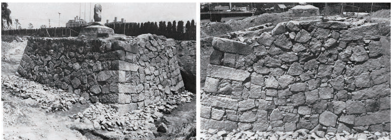
外郭櫓台検出状況
