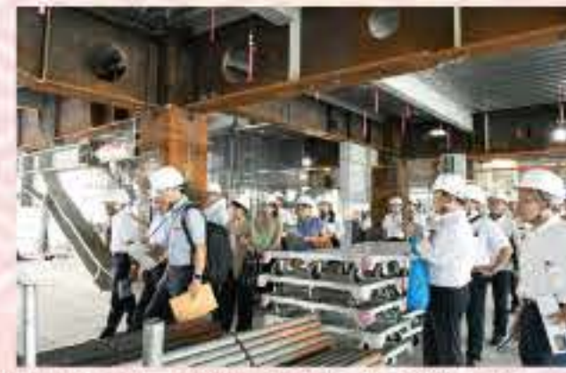
基町相生通地区市街地再開発事業の高層棟及び変電所棟新築工事現場視察(8/7)
